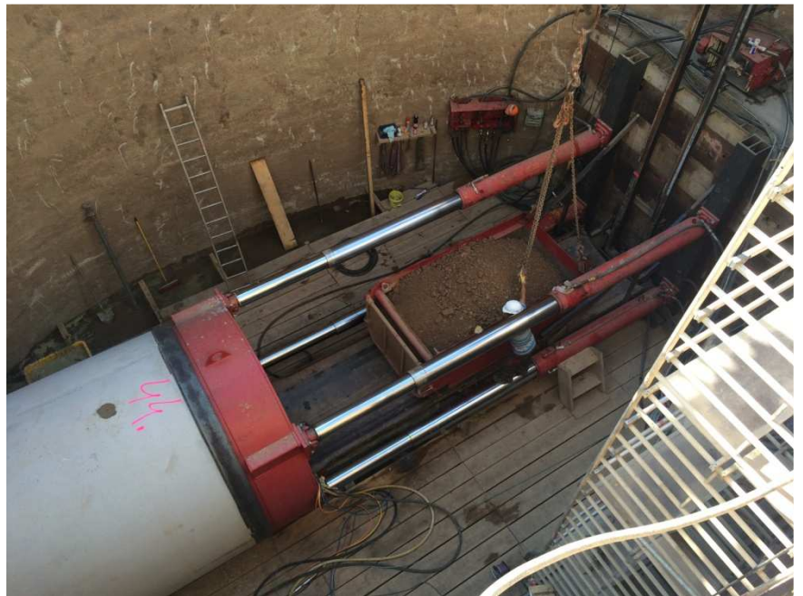
Blick in die ovale Pressgrube, Abmessung Grundfläche 12,5 x 9,5 m
