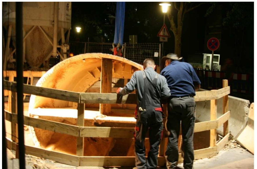
Zentimeterarbeit bei der nächtlichen Bergung der Vortriebsmaschine an der Zielgrube vor dem „Blauen Turm“ der SRH Hochschule. Da die Zielgrube auf Grund der Örtlichkeit nur einen Durchmesser von 5 m aufwies, musste die Vortriebsmaschine zur Bergung zerlegt werden. Hier im Bild ist der Haubenschild mit Zwischenbühne zu sehen.
